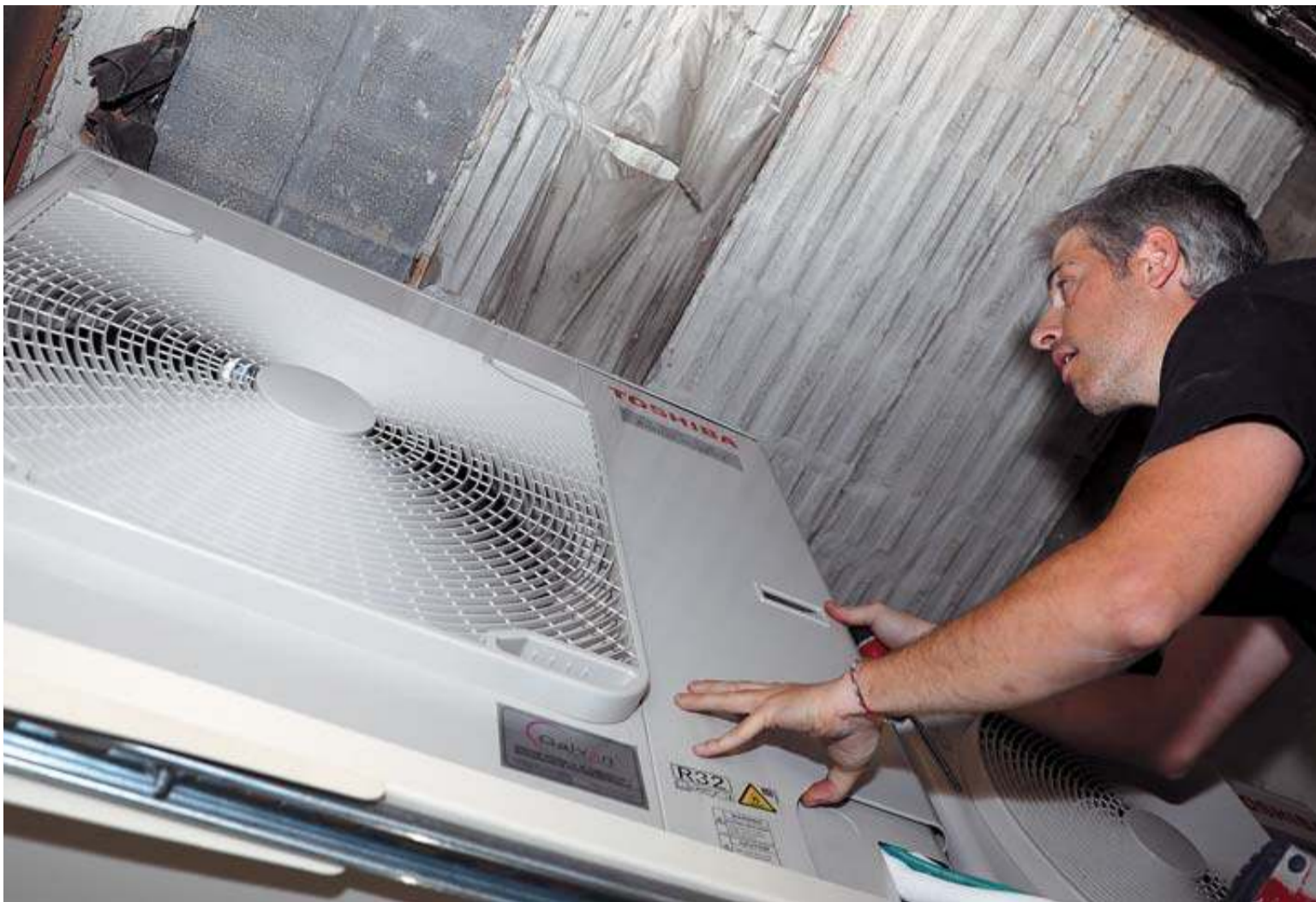
Un trabajador de Galván Frío Industrial instala un dispositivo de refrigeración en un establecimiento de la calle Amaya de Pamplona.
